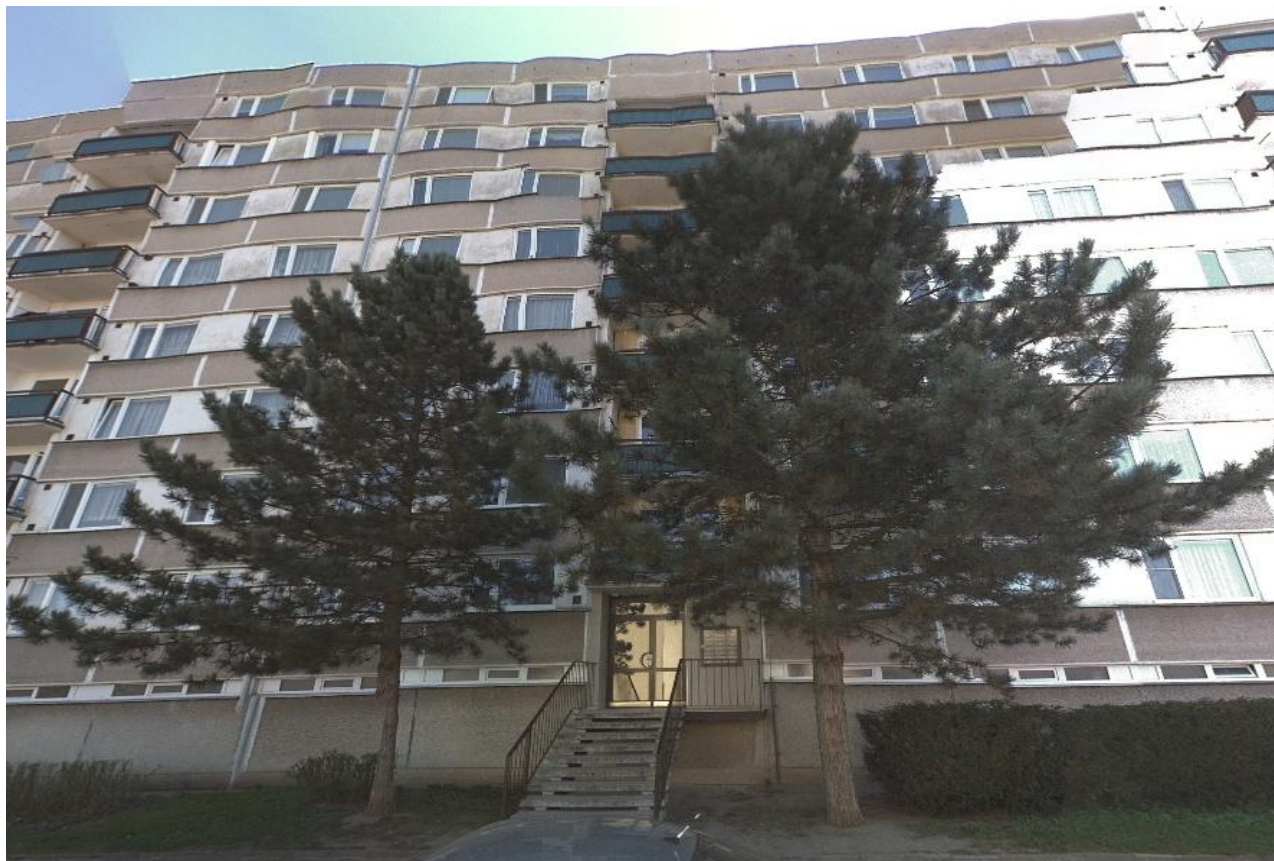
Vstup do budovy č.p. 325
