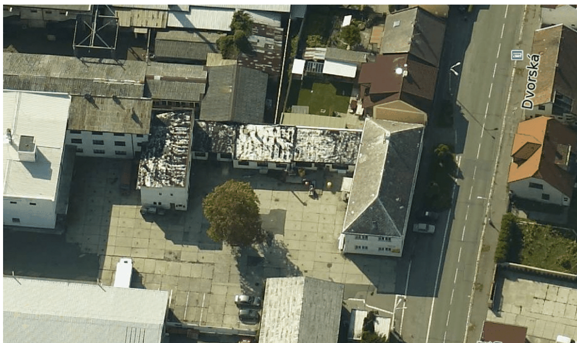
Budova bez č.p./e.č. na p.p.č. 267/4 a nádvoří p.p.č. 267/5
