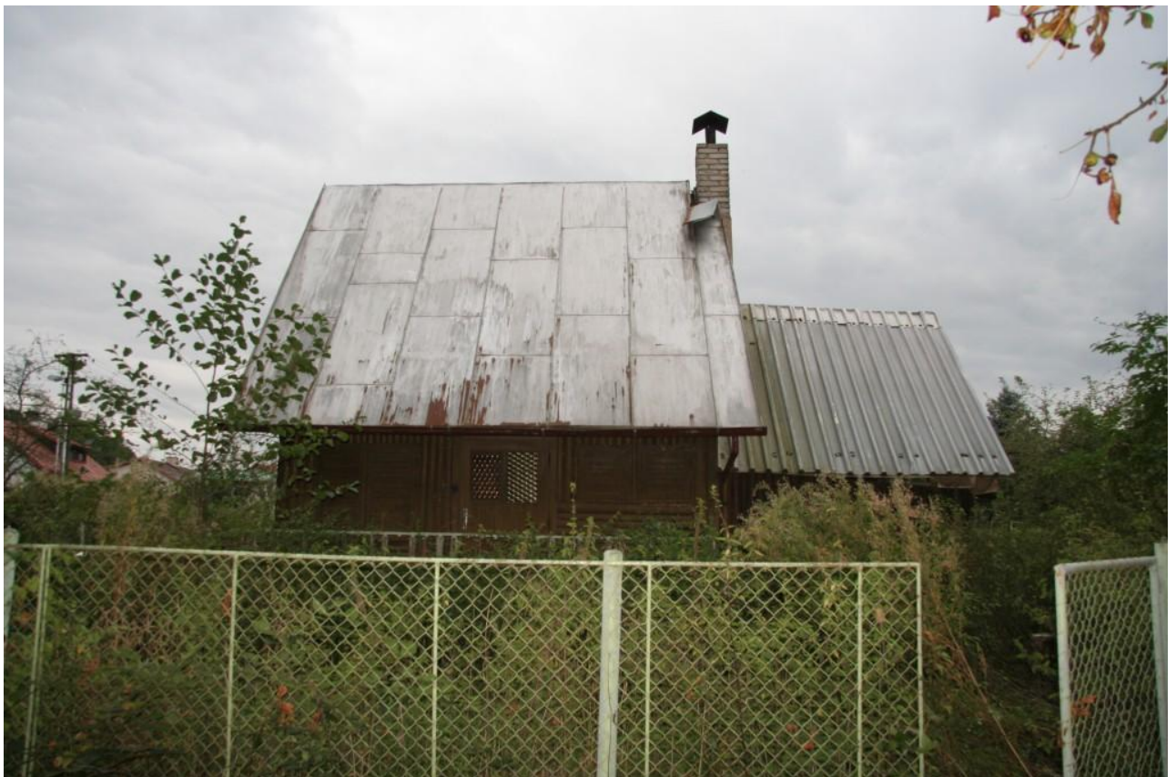
Pohled z přístupové cesty
